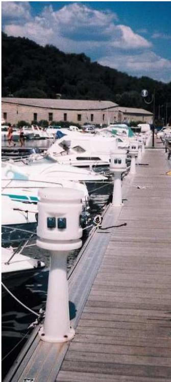
Cette borne est conçue pour une implantation harmonieuse et discrète dans les campings ou les lieux publics. Sa résistance à la corrosion et son étanchéité la rendent particulièrement adaptée à une utilisation en extérieur pour l'alimentation en eau et en électricité des campings.
